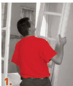
1. Dégondage des ouvrants.
