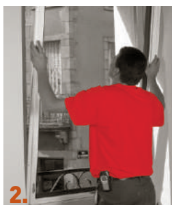
2. Mise en place de la nouvelle menuiserie.
