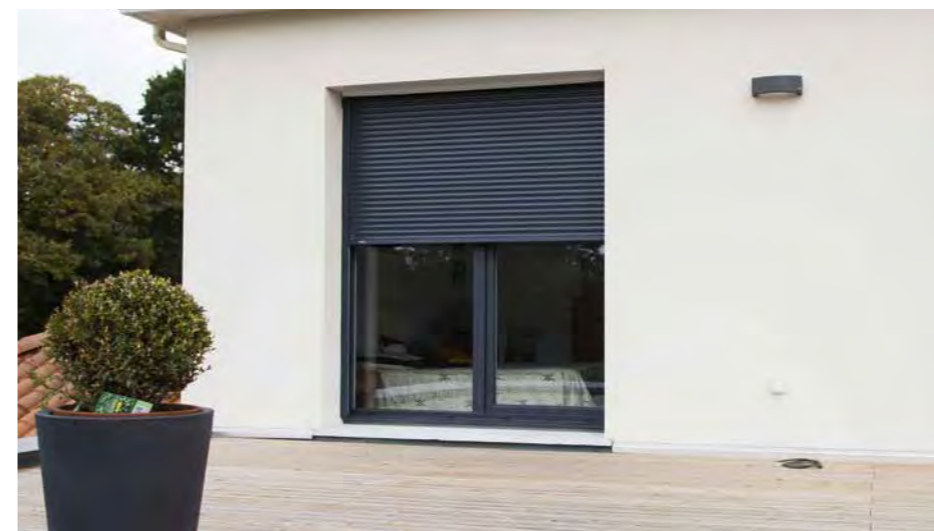
Volet roulant demi-linteau assorti à la couleur de la menuiserie
