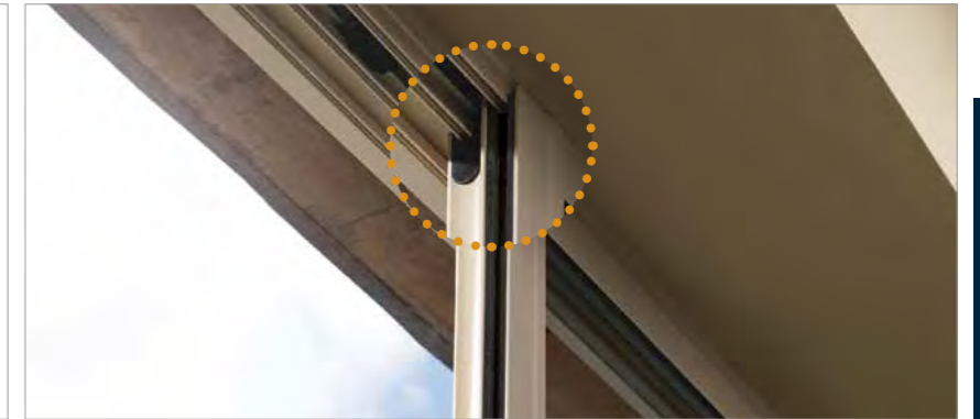
Système anti-soulèvement.
