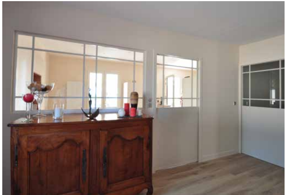
Ensemble composé de verrière aluminium et portes coulissantes aluminium FACTORY posées dans un chassis à galandage
